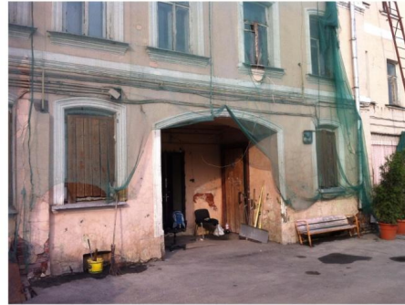
Вид с дворовой территории (по состоянию на апрель 2012г.).
