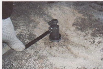
Фото 10. Установка анкера для испытаний стяжки пола методом отрыва со скалыванием.
