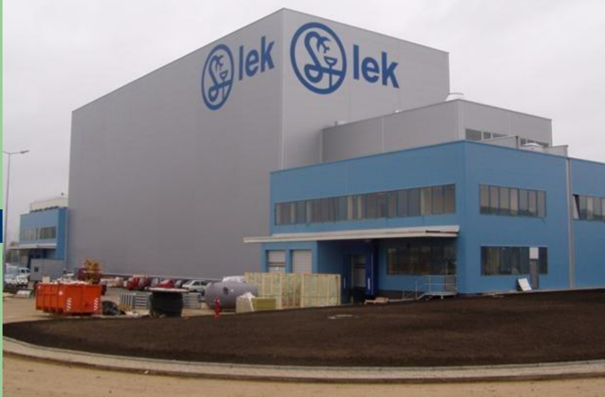
Автоматический высокостеллажный склад на заводе «Лек», г. Стрыков, Польша
