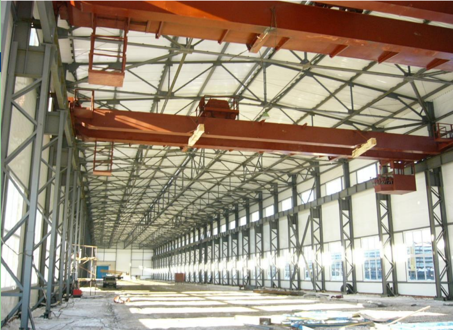
Каркасное промышленное здание
