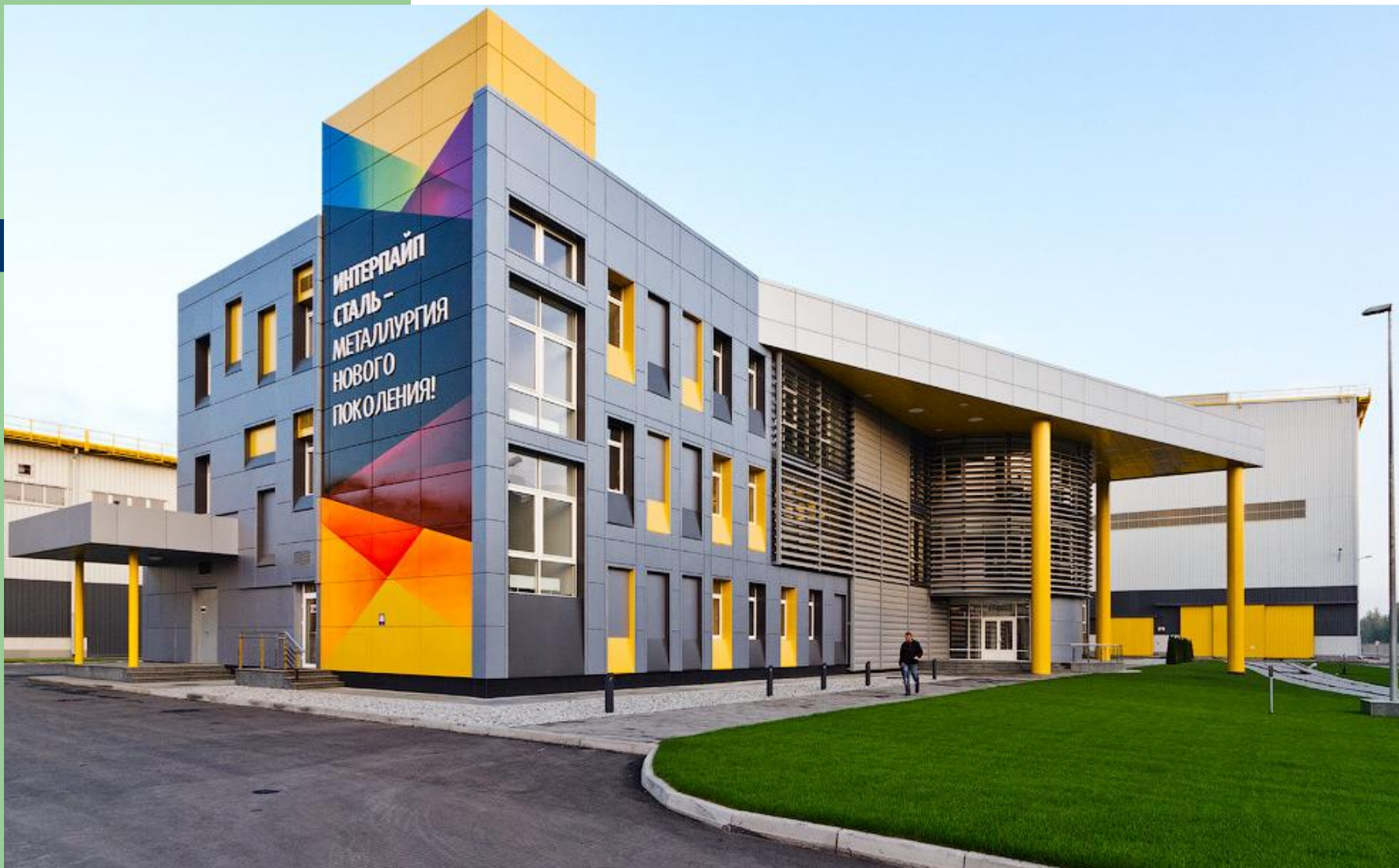
Административно-бытовое здание завода
