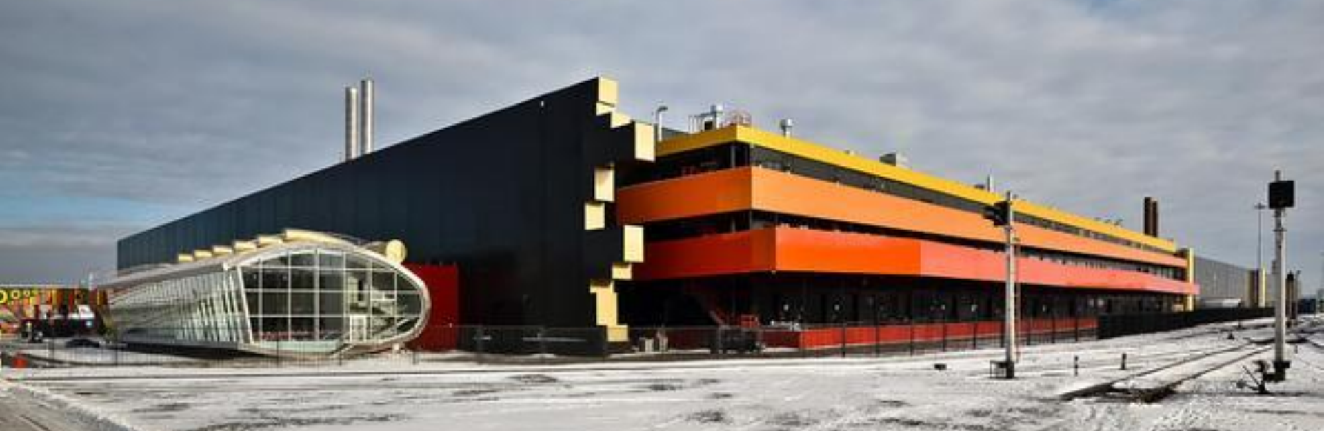
Цех ««Высота 239» Челябинского трубопрокатного завода
