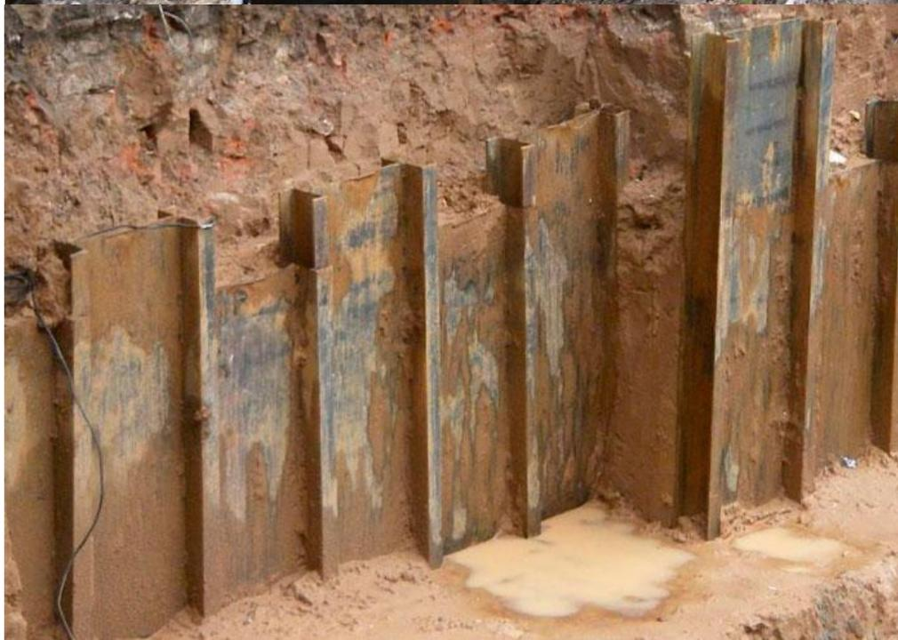
Рис. 14.4. Профили прокатного стального шпунта:
