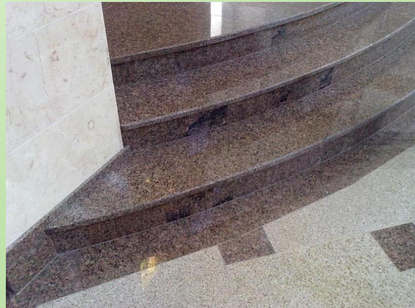
**3) Ступени для крыльца из полированного гранита с полосами противоскользения.**
