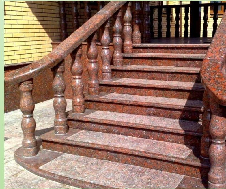
2) Ступеньки для крыльца полированного гранита с термообработанной основной частью поверхности.
