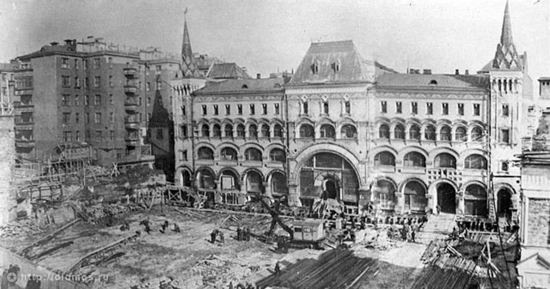
Передвижка Саввинского подворья. Москва, ул.Горького (Тверская), 1939 г.
