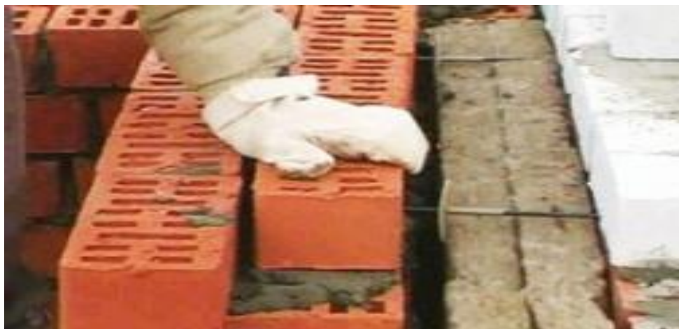
Рисунок 23(д) –Гибкие связи http://klademkirpich.ru/operacii/osobennosti
