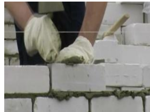
Рисунок 5-Кладка из силикатного кирпича
