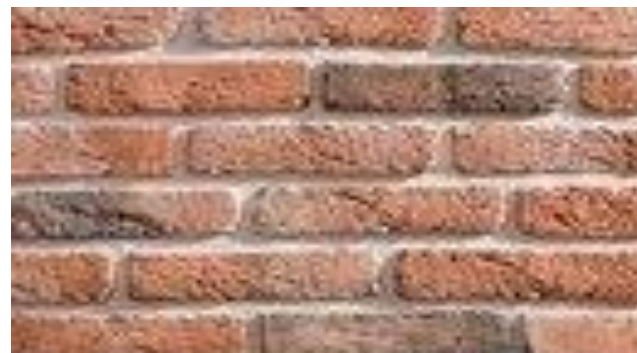
Рисунок 7- Ряды кирпичной кладки http://masterotvetov.com/uploads
