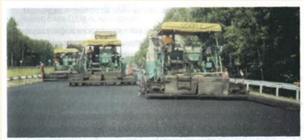
Рис. Укладка смеси на полную ширину проезжей части
