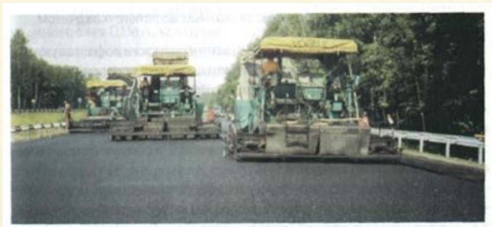
Рис. Укладка смеси широкозахватным асфальтоукладчиком
