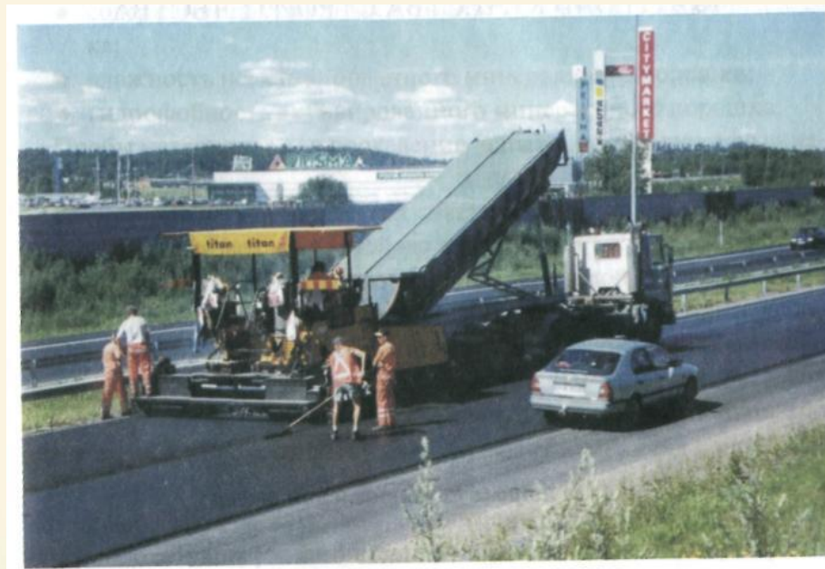
Рис. Укладка ЩМА одним асфальтоукладчиком
