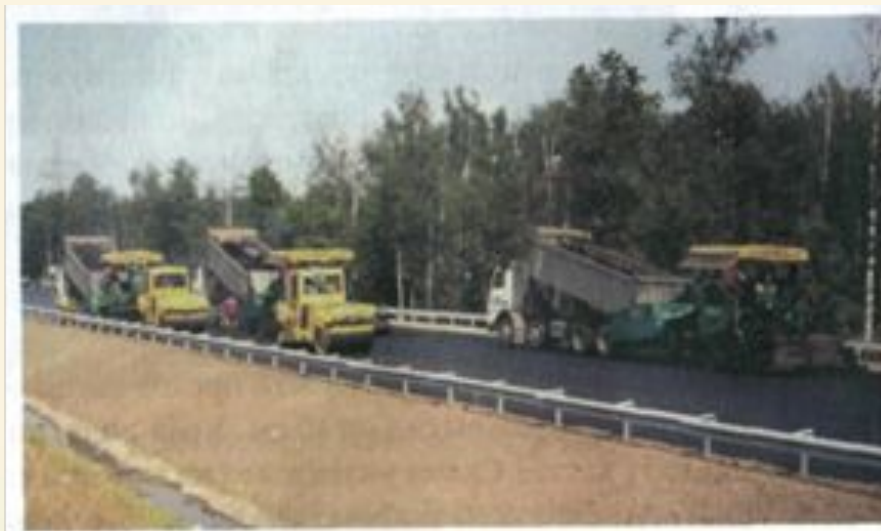
Рис. Устройство покрытия из ЩМА
