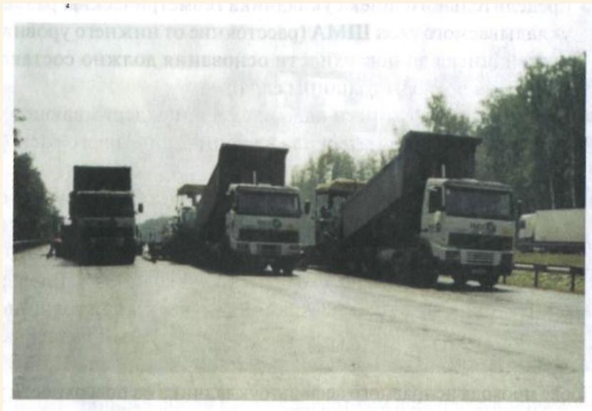
Рис. Загрузка ЩМАС в бункера асфальтоукладчиков
