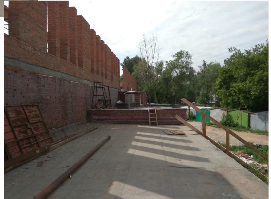
Административное здание, Новосибирск, ул. Галушца, 3/1.
