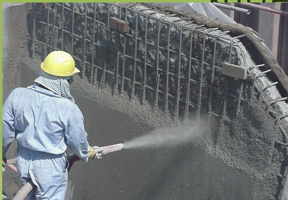
«Мокрый» способ торкретирования
