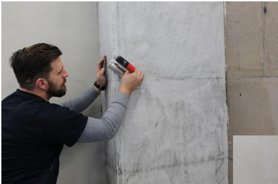
Шаг 7 – удалить наплывы на углах для создания нужной геометрии
