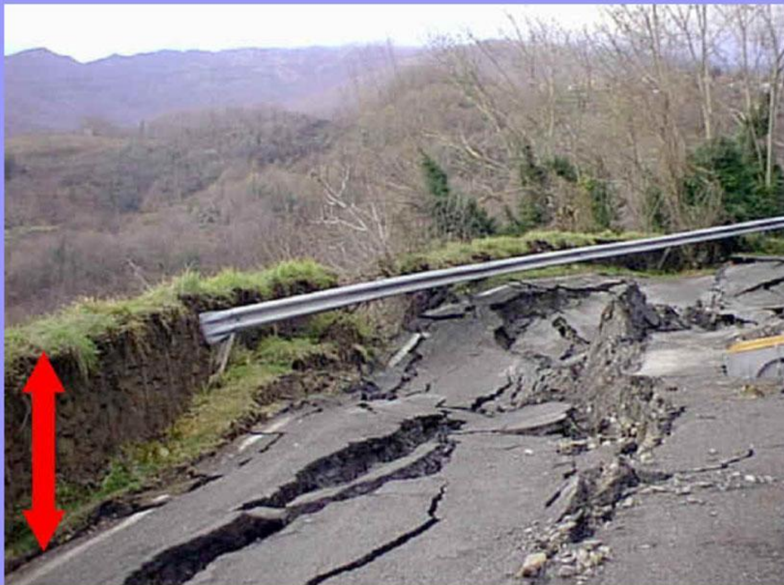
Разрушение откоса насыпи на а/д Пермь -Ижевск
