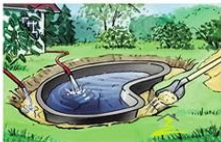
Заполнить песком пространство вокруг пруда
