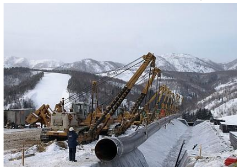
Укладка изолированного трубопровода в траншею
