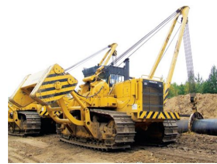
Укладка изолированного трубопровода в траншею
