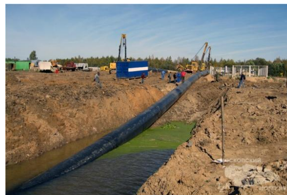
Строительство подводного перехода
