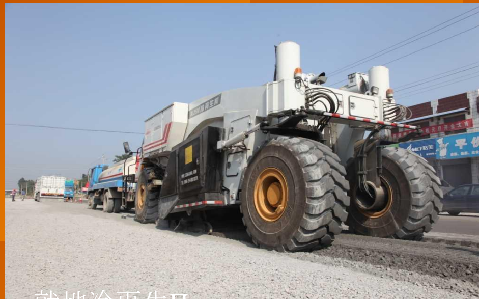
就地冷再生Повторное использование асфальта на месте
