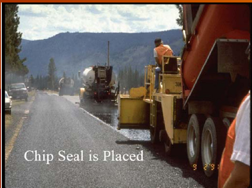
碎石封层施工 Строительство
