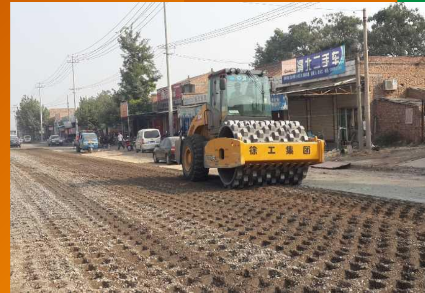
初步压实Предварительное уплотнение
