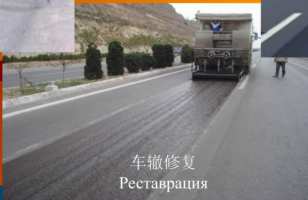
车辙修复后的路面 После реставрации колеи
