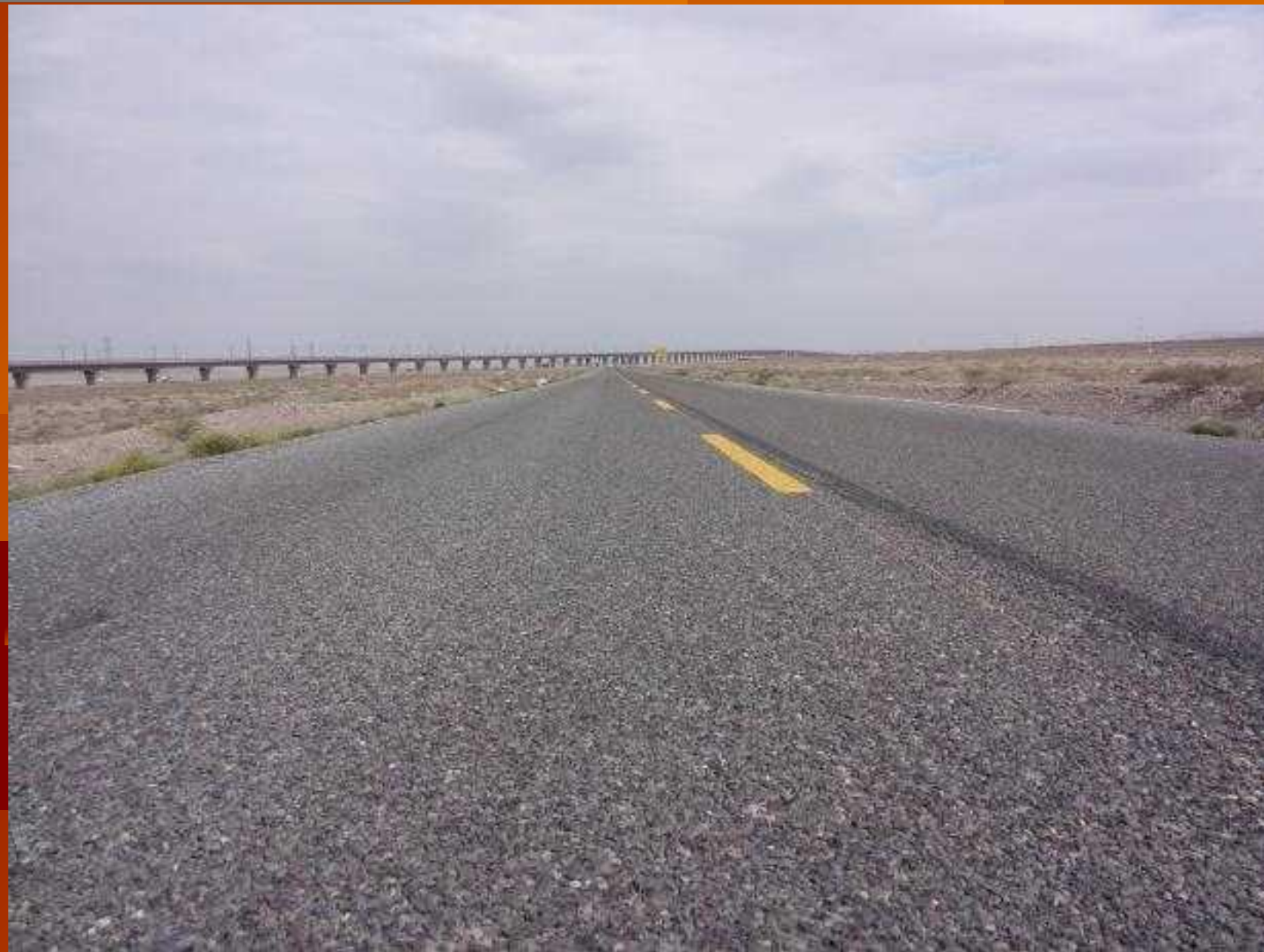
高速公路开普封层预防性养护工程（中国 甘肃）
