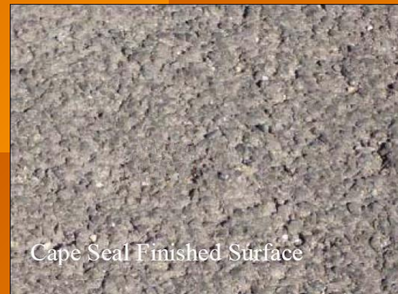
路面成型-开放交通 формирования дорога- открытие движения
