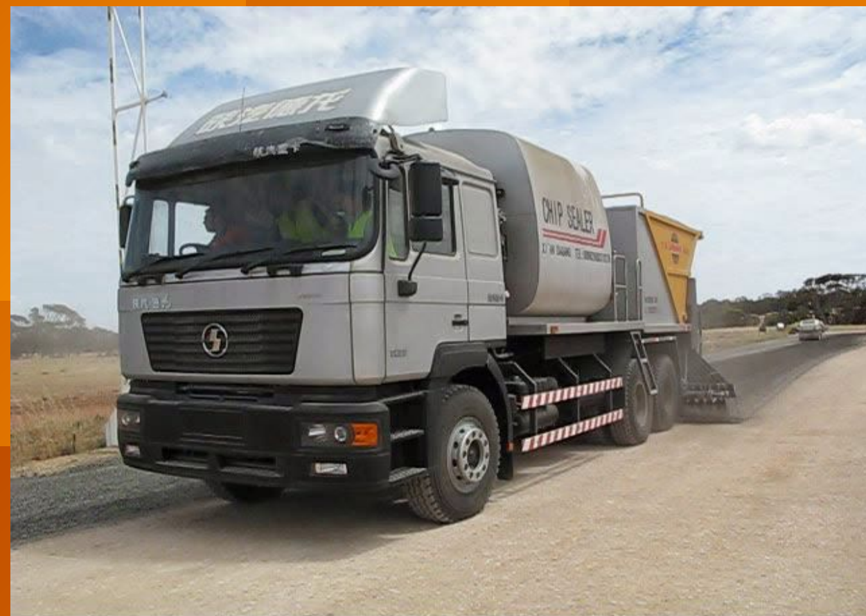
同步碎石封层施工 (澳大利亚) Фото строительства(Австралия)
