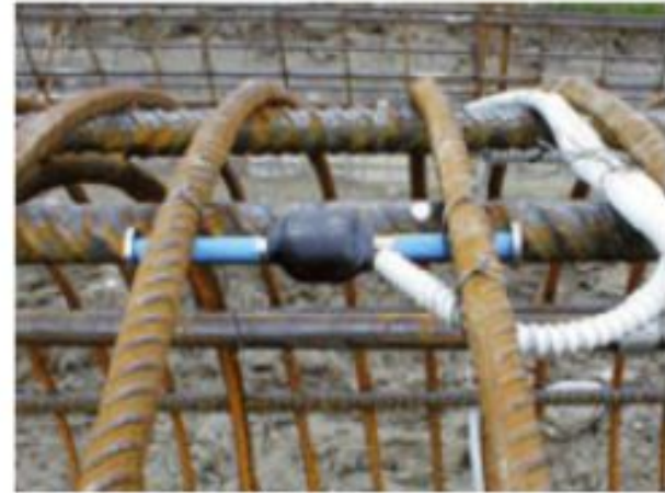
Установка вибрационного датчика деформации на арматуру
