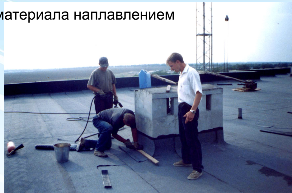
Устройство примыканий к вертикальным поверхностям
