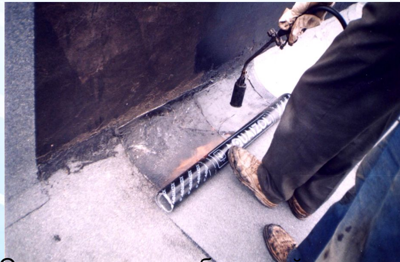
Оплавление слоя битумной мастики газовой горелкой
