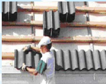
Укладка черепицы на обрешетку
