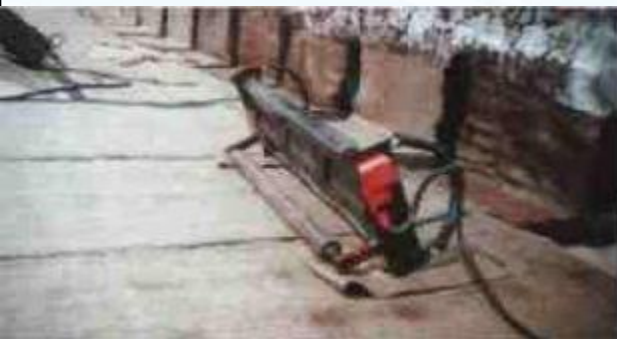
Кровельная машина ИКО-1000 для устройства примыканий (облегченный вариант машины «Луч»).
