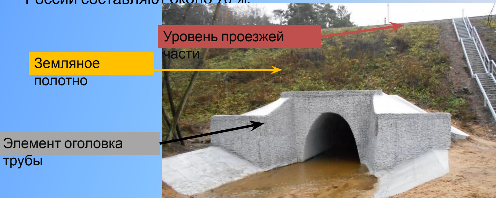
Схема расположения трубы в теле земляного полотна дороги
