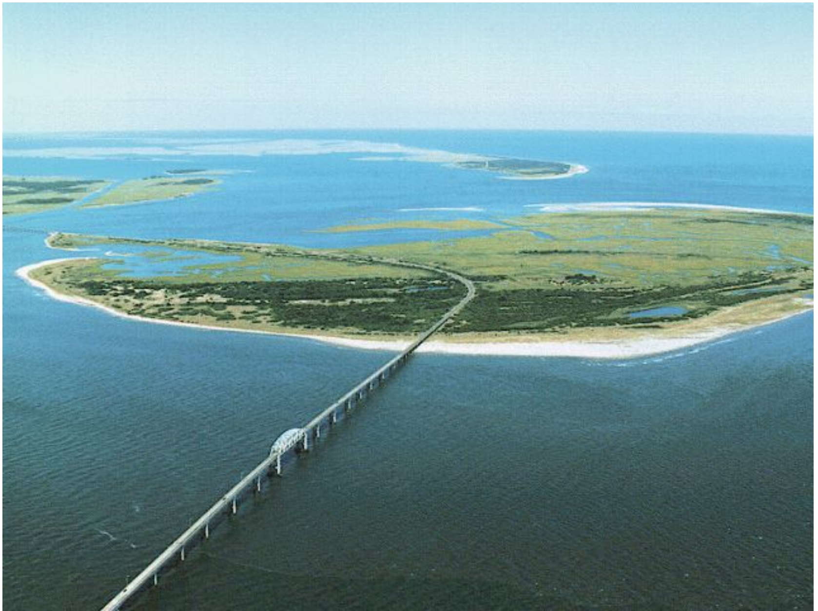
Мост-туннель в Вирджинии, США
