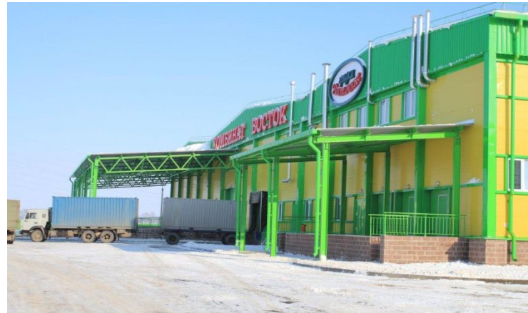
Картофелеплодоовощехранилище на 22,5 тыс. тонн
