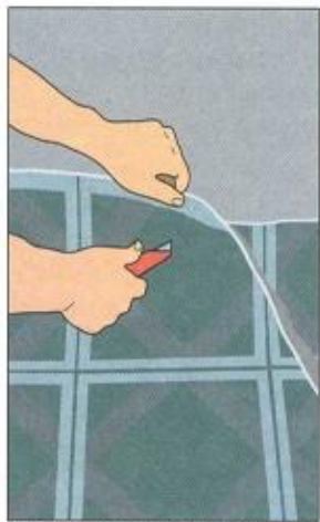
Предварительная обрезка линолеума вдоль стен
