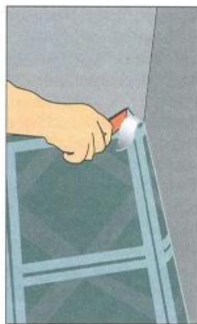
Обрезка линолеума на внутренних углах
