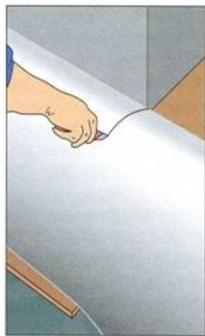
Обрезка линолеума на внешних углах
