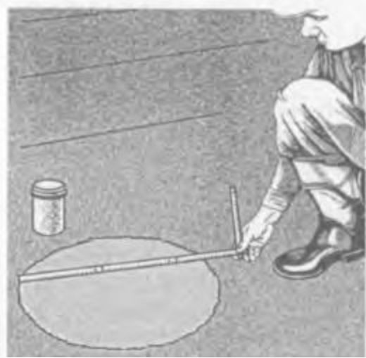
Рис. 15. Контроль подвижности растворной смеси наливного пола
