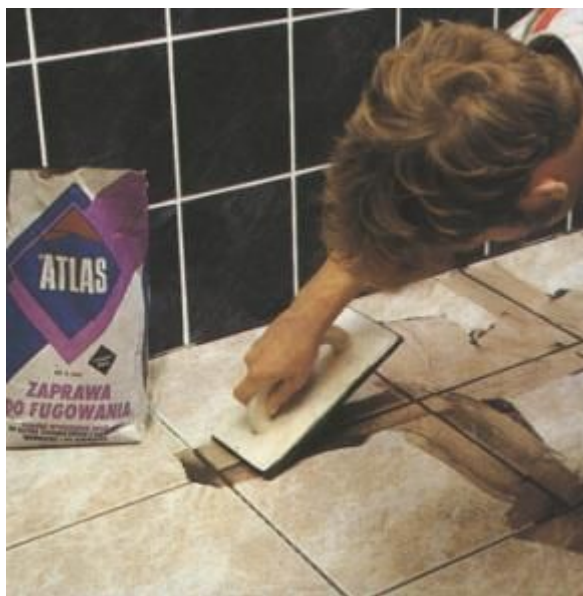
Заполнение раствором швов между напольными плитками
