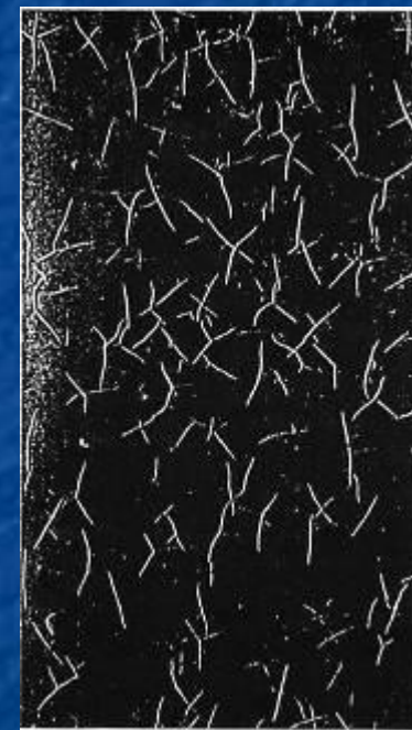
Образование трещин лакокрасочного покрытия в виде «птичьих следов».
