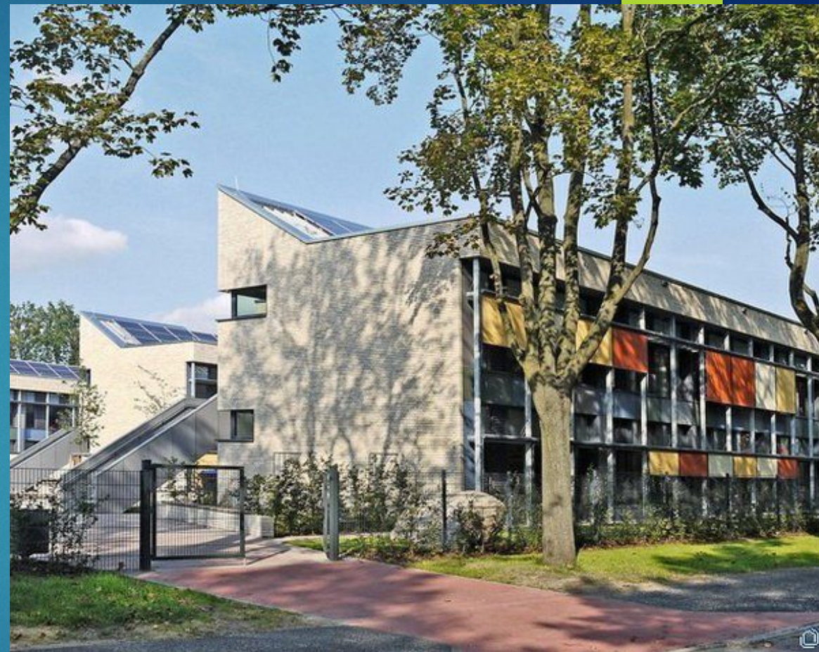
▶ Энергоэффективное здание школы, Хоэн-Нойендорф, 2010 г.
