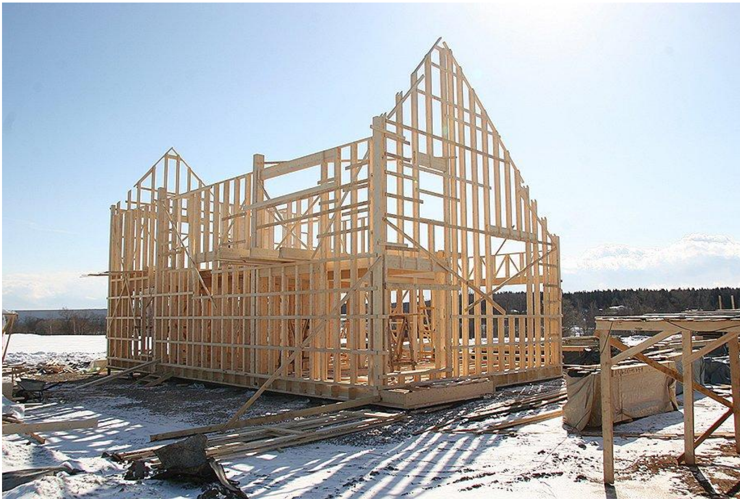
Рис. 7. Процесс строительства активного дома
