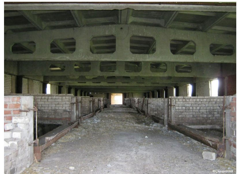
Железобетонная балка с решетчатой стенкой
