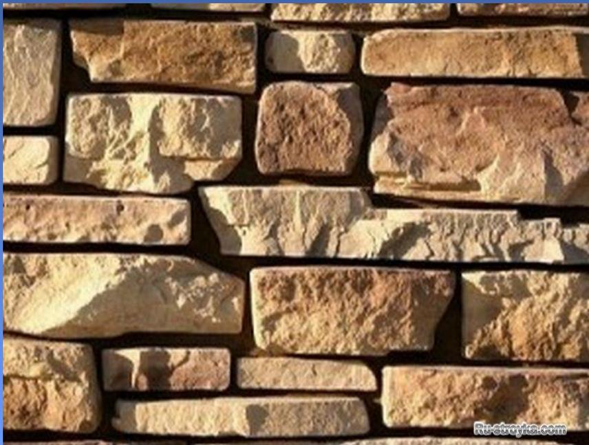
Каменная кладка — это конструкция из камней, уложенных на строительном растворе в определенном порядке. Процессы по возведению конструкций из кирпича, мелких блоков называются каменными работами. В зависимости от применения и степени сложности кладки подразделяют на следующие группы:
