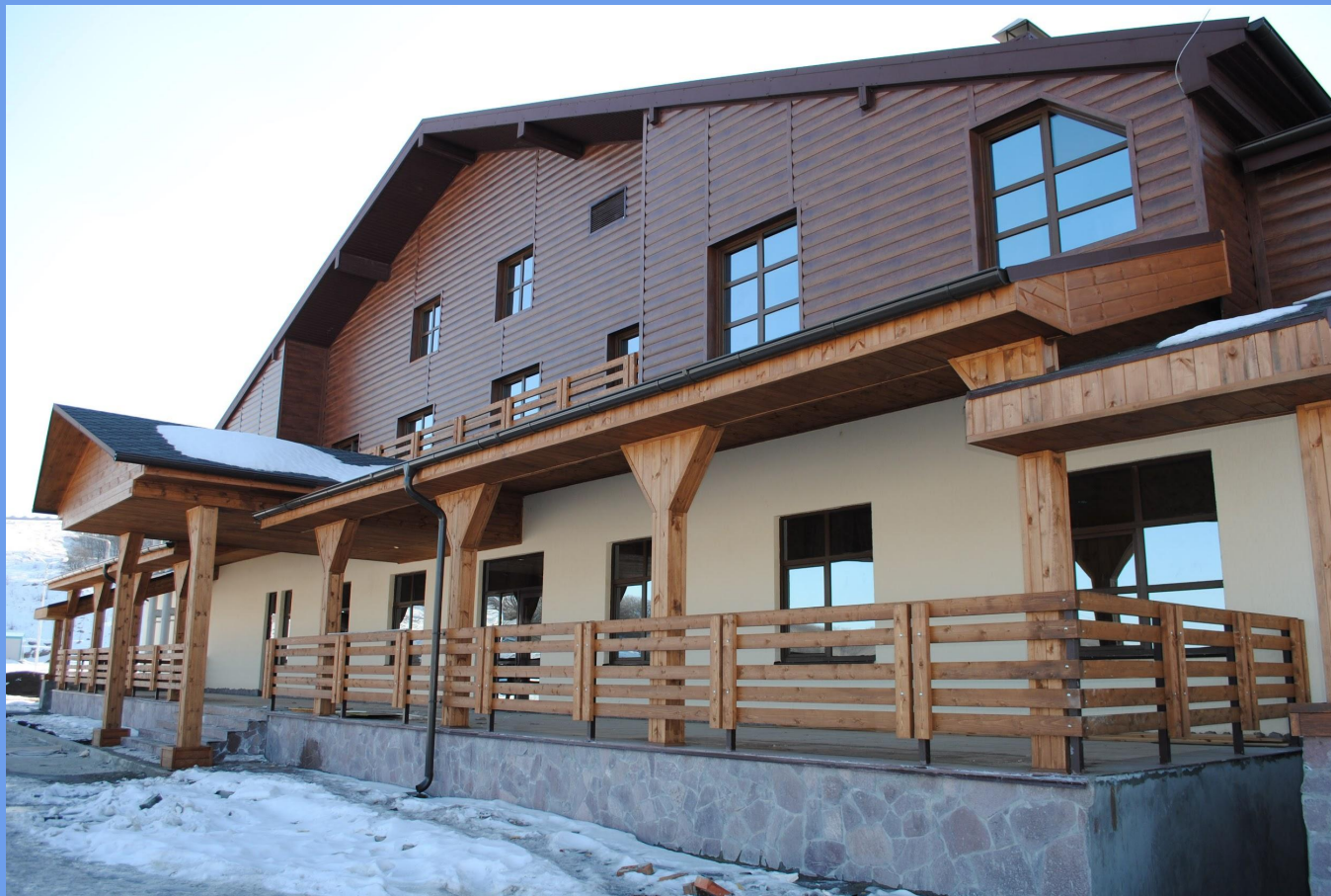
КУЛЬТУРНО ОЗДОРОВИТЕЛЬНЫЙ КОМПЛЕКС “АЛЬПИКА” (ОСТЕКЛЕНИЕ И ФАСАДНЫЕ РАБОТЫ) г. Белгород
