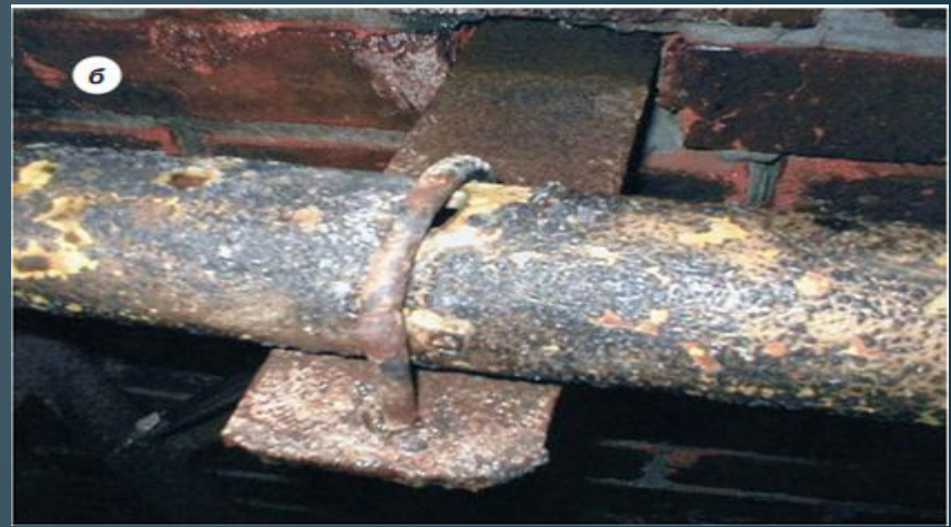
разрушение газопровода;
