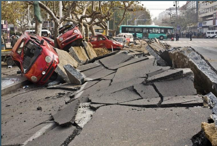
Разрыв газопровода ОАО «Юггазсервис» в г. Новороссийске
