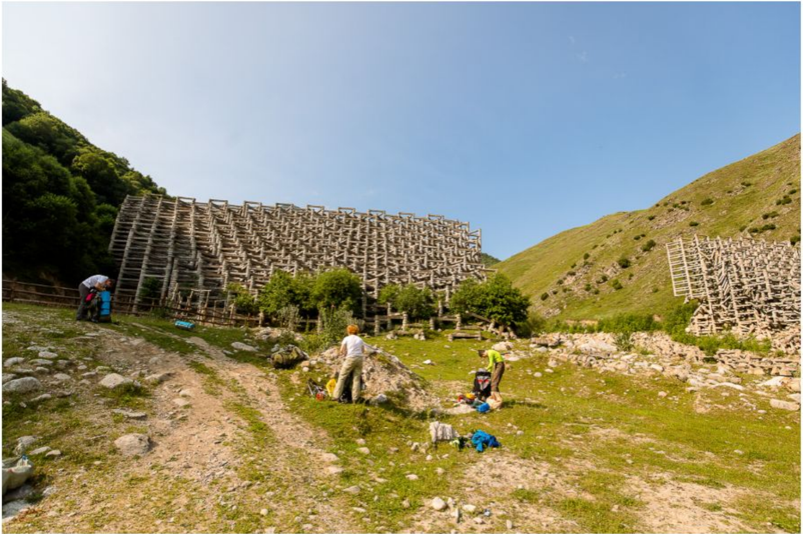
Фото 1. Разрушенная противоселевая дамба на р.Герхожансу
