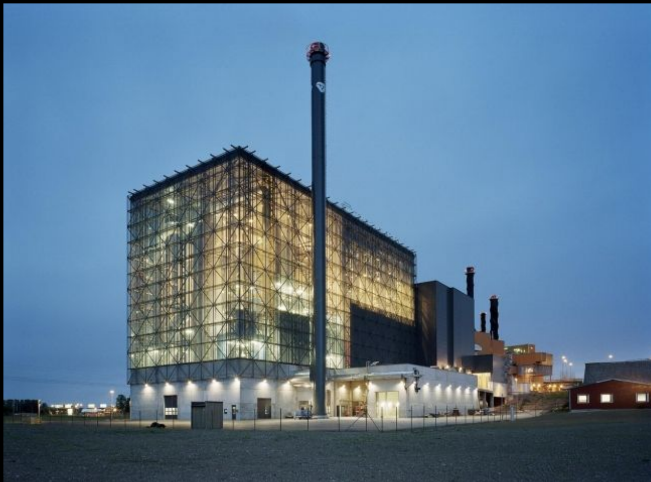
Мусоросжигающий завод в Швеции
