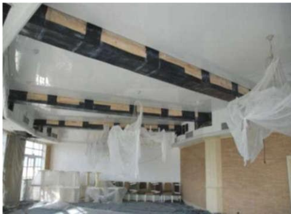
Усиление балок перекрытия в здании гольф-клуба, Болгария
