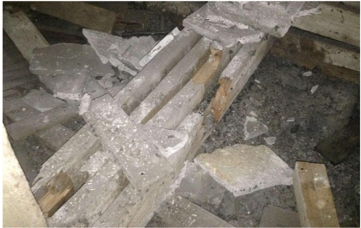
Разрыв нижнего пояса сегментной фермы
