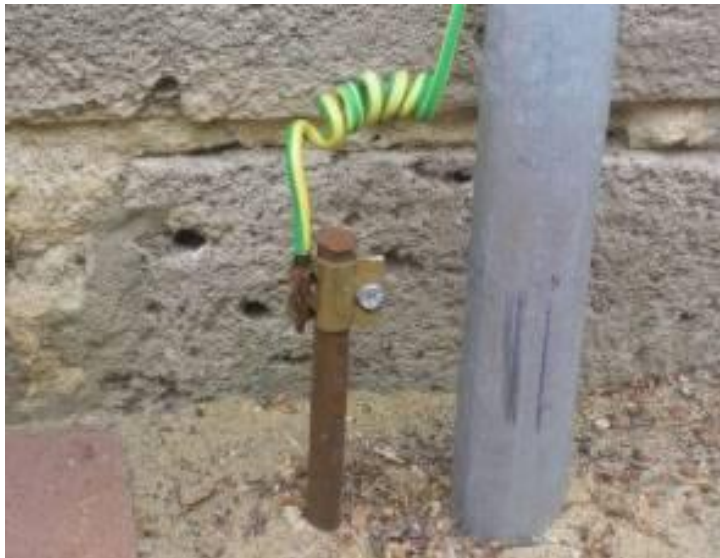
Заземление опор освещения
