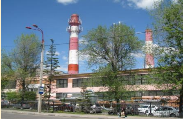
Котельная №21 ул. Звездная
