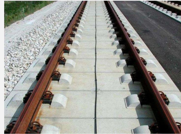
Рисунок 14 – Плиты безбалластного мостового полотна
