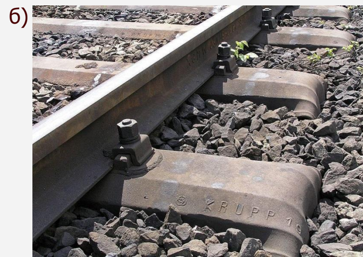
Рисунок 15 – Металлические шпалы
