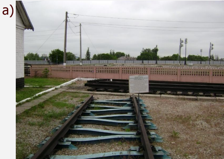
Рисунок 15 – Металлические шпалы
