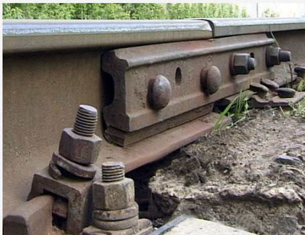
Рисунок 8 – Переходная накладка Р65 - Р75
