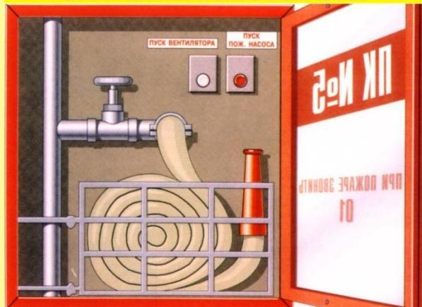
Предназначен для тушения пожаров водой от внутреннего водопровода жилых, административ. и производственных помещений (кроме электроустановок под напряжением).
