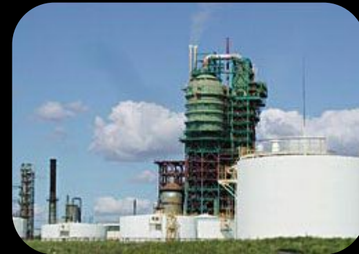
Установка каталитического крекинга на Ярославнефтеоргсинтезе, пущена в 2000 году после коренной реконструкции. Аппарат большого диаметра на этажерке - регенератор.
