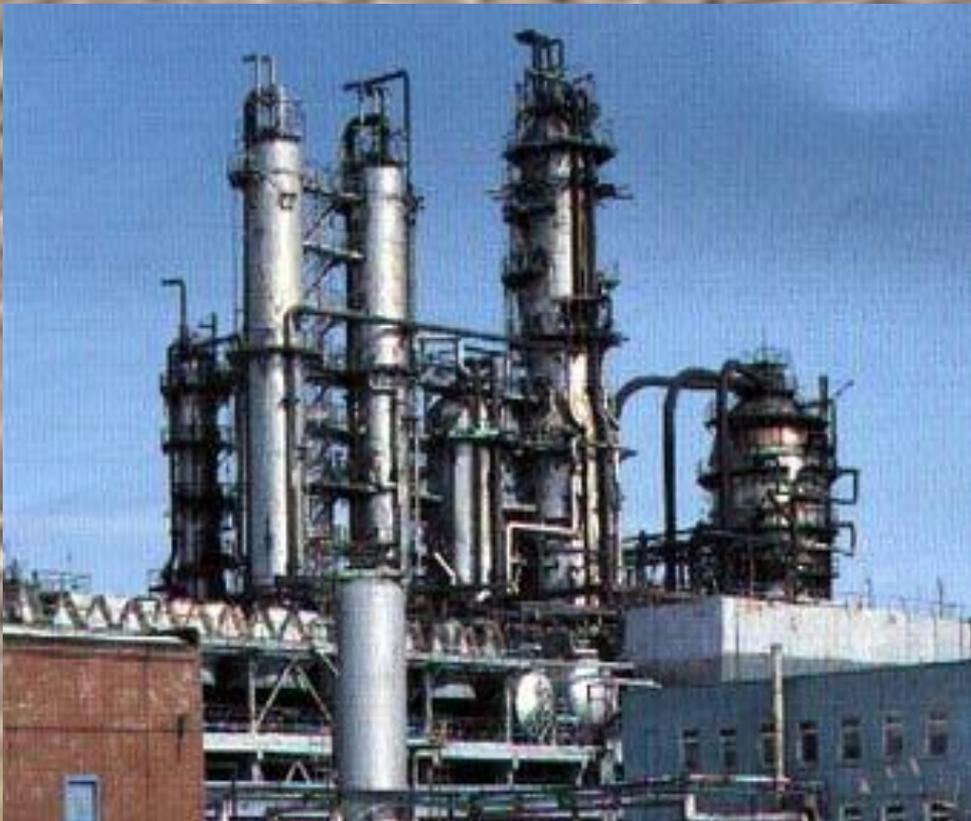
Слово “крекинг” означает расщепление. На крекинг - заводах углеводороды не перегоняются, а расщепляются. Процесс ведётся при более высоких температурах, часто при повышенном давлении. При таких температурах крупные молекулы углеводородов раздробляются на более мелкие. При крекинге нефть подвергается химическим изменениям. Меняется строение углеводородов. В аппаратах крекинг - заводов происходят сложные химические реакции. Эти реакции усиливаются, когда в аппаратуру вводят катализаторы.
