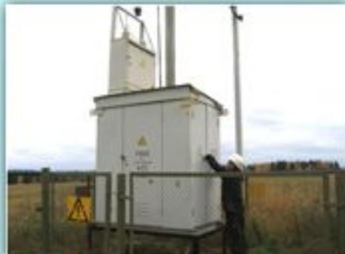
Рис. 22. Монтаж станции катодной
