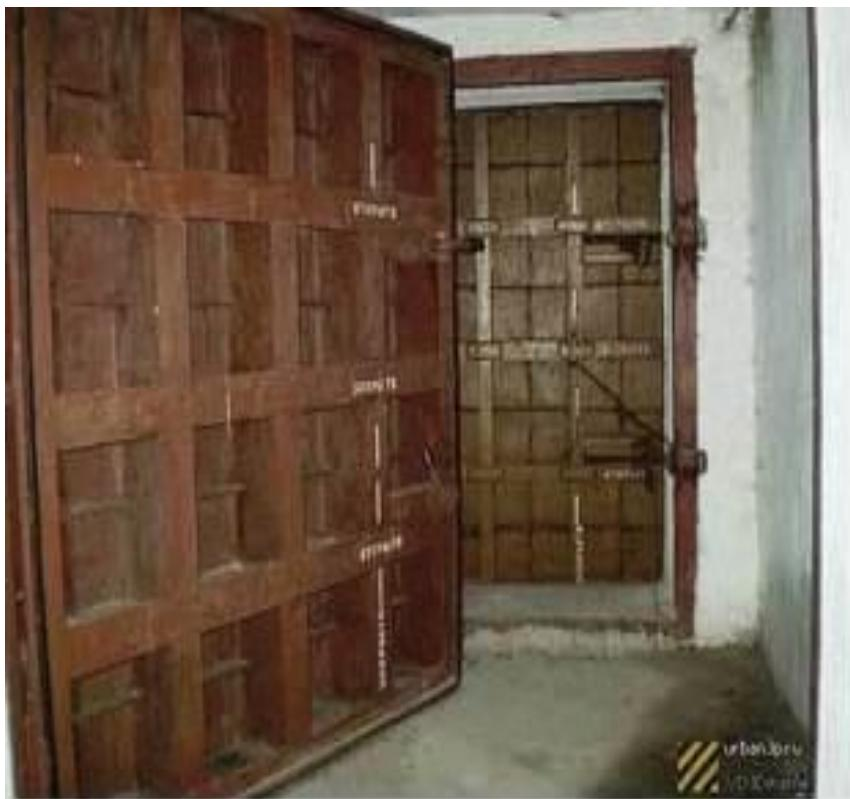
Защитно-герметические (дальние) и герметические (ближние) ворота
