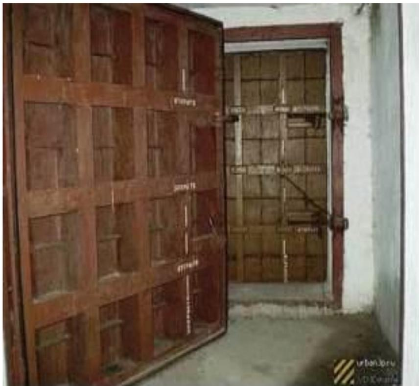
*Защитно-герметические (дальние) и герметические (ближние) ворота*
