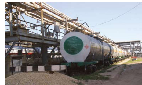
Сұйық күкіртті темір жол цистерналарына құю эстакадасы
