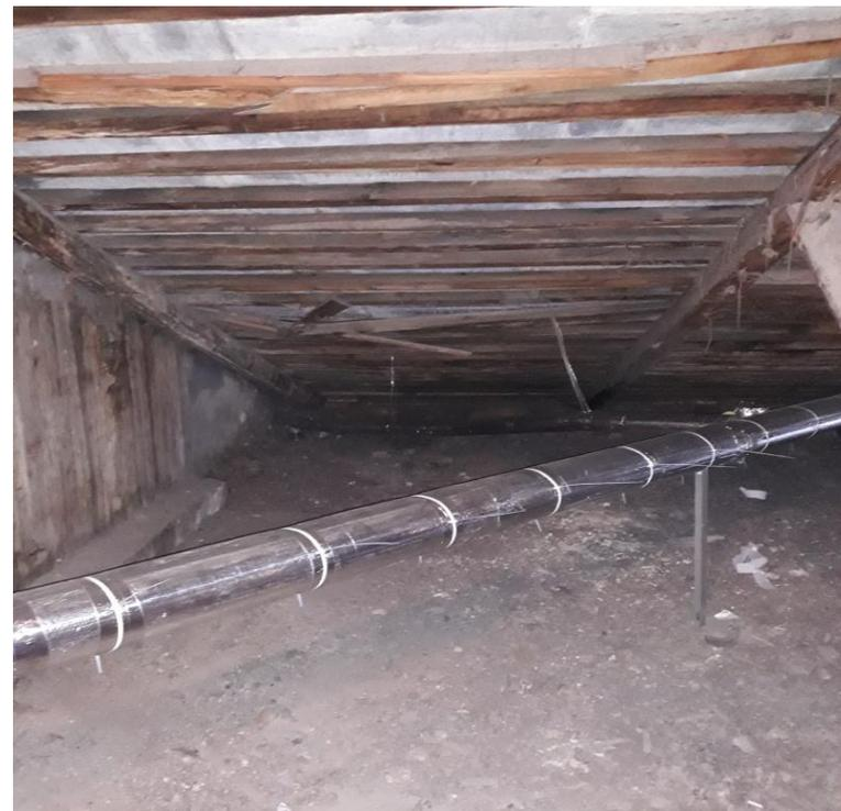
**Восстановление изоляции трубопроводов центрального отопления вентиляционных каналов и теплоизоляция межэтажного перекрытия в чердачном помещении по адресу: Лиговский пр., д. 171**
