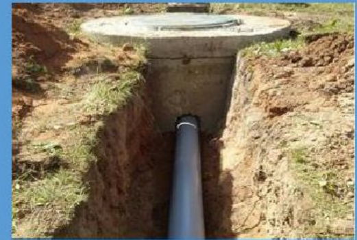
Система закрытой ливневой канализации
