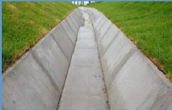
Водотводные железобетонный кюветы
