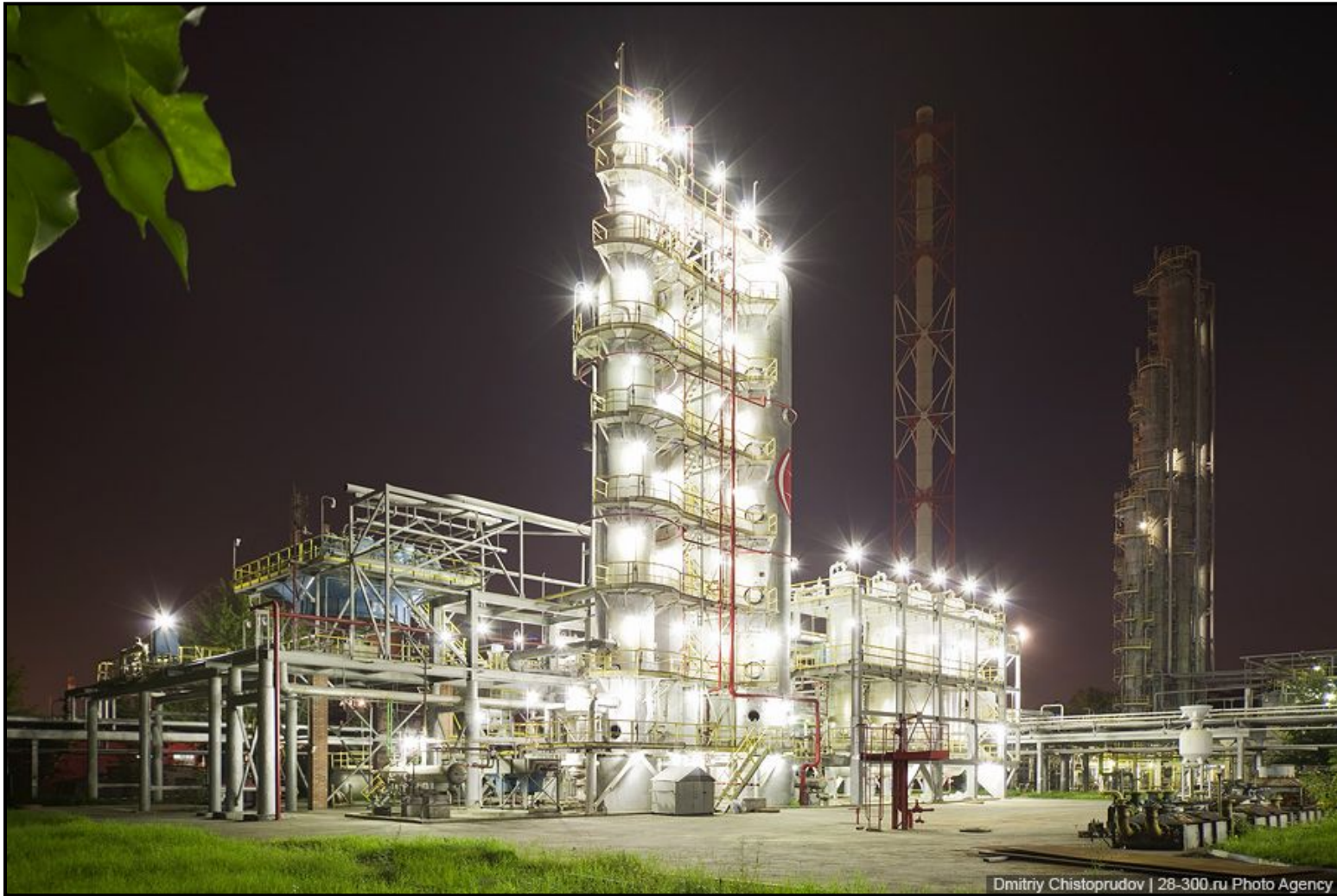
Рисунок 4. Технологическая Комбинированная установка по производству МТБЭ ОАО «ГАЗПРОМНЕФТЬ-МНПЗ»
