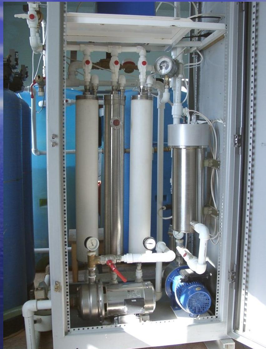
Станция водоподготовки особо чистых биопрепаратов 3 м/ч
