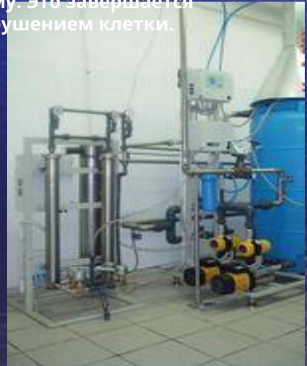
**Дозы озона в зависимости от состава обрабатываемой воды, составляют до 5 мг/л, время контакта озono-воздушной смеси с водой для гарантированного эффективного окисления органических примесей 15 мин.**
