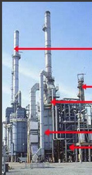
Рис.9. Установка каталитического риформинга с периодической регенерацией катализатора на НПЗ компании Shell с предварительной гидроочисткой сырья
