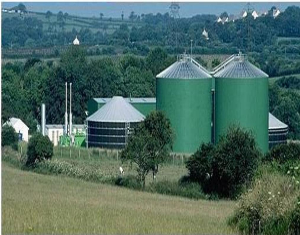
Установки переработки методом метанового сбраживания без доступа кислорода отходов сельскохозяйственного производства (помет птицы, навоз, бытовые отходы, фекалии, отходы пищевой промышленности и т.п.)
