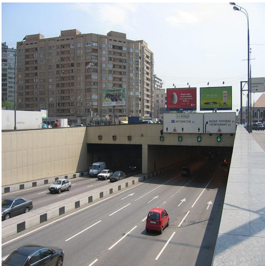
Северный портал Лефортовского тоннеля
