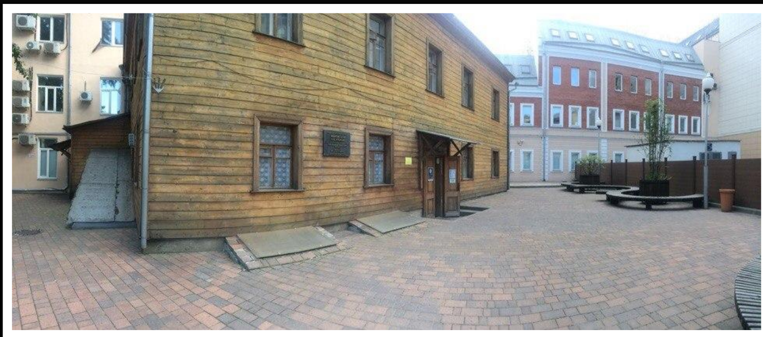
Вид с фасада дома
